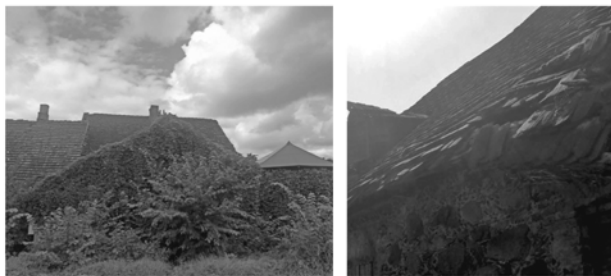
39 pav., 40 pav. Pietinė Krošinskių pilies pusė su išlikusiomis čerpėmis. Šiaurinės pusės stogo dalies, dengtos čerpėmis, fragmentas. 2021 m. rugpjūčio 29 d. RIMVYDO UŽUKUKIO NUOTR.
