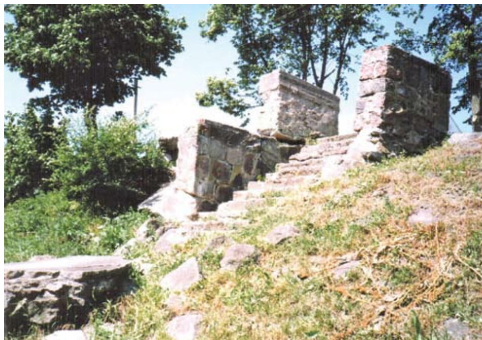
Smalininkų vandens lygio matavimo stotis prieš restauraciją. 2002 m.
